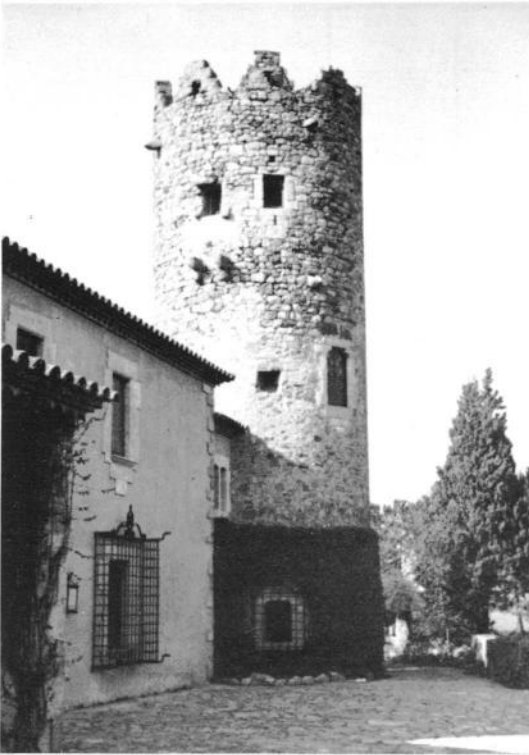
Torre del mas Sureda, Ermedàs (Palatrugell). S'ha reformat molt. Algunes de les finestres no són originals.
